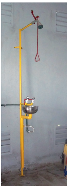
Foto 6: dispositivo para lavado de ojos en depósito de fitosanitarios. EEA INTA Delta. Foto: Florencia Trabichet.
