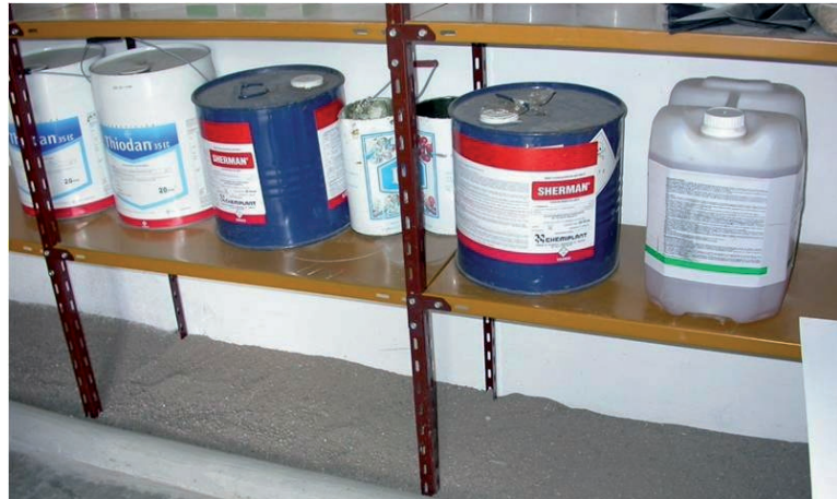
Foto 4: los estantes deben ser de materiales no absorbentes y se debe contar con estructuras antiderrames. En la foto se puede apreciar un zocalo antiderrames.
